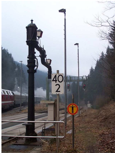
Sehr eindrucksvoll der Wasserkran am Bahnsteig 1 Früher wurden hier immer die „Dampfer“ bedankt
